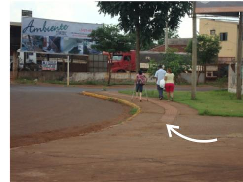
Piso podotátil sem continuidade de indicação de alerta junto a local com saída de veículos.
