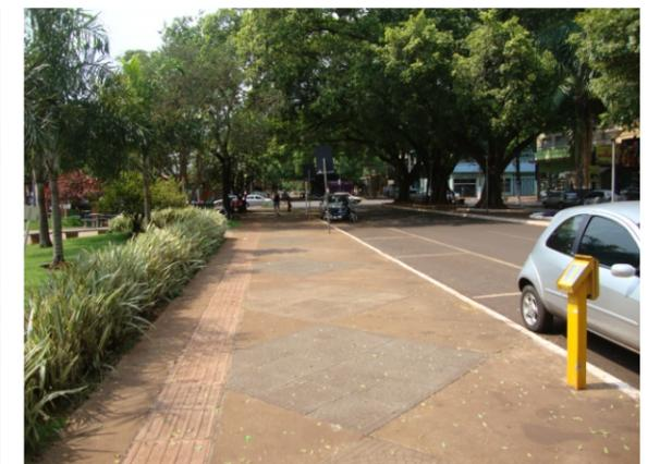
Passeio público implantado de forma qualificada e com posicionamento seguro do piso podotátil.
