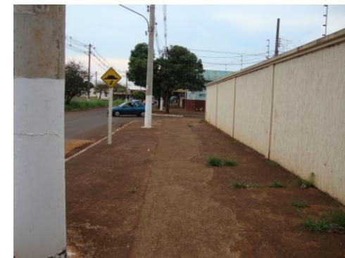
Calçada sem piso podotátil e rampas para PNEs.
