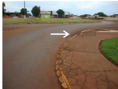
Degrau entre rampa de PNE e o leito carroçável, aliado a deterioração do pavimento traz riscos aos pedestres.
