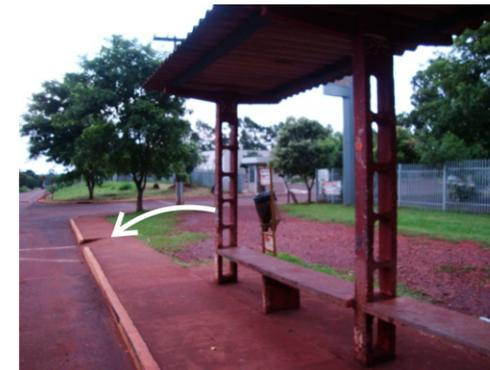
Abrigo de ônibus mal conservado e rampa de PNE sem correspondência ou continuidade.
