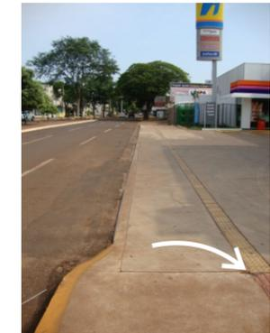
Piso tátil colocado de forma correta conforme a Norma.
