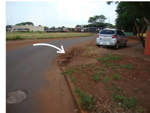
Falta continuidade da pavimentação da calçada e bueiro sem manutenção trazendo risco ao pedestre.
