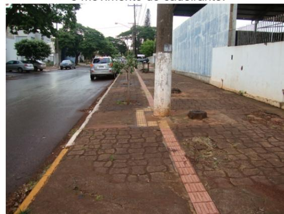
Piso podotátil implantado em faixa inadequada do passeio, além de conter obstáculos.
