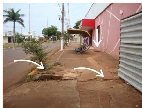
Falta de continuidade do piso podotátil junto ao ponto de ônibus acaba trazendo risco aos pedestres, além de degrau e buraco na calçada.
