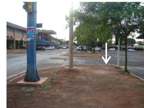
Rampa em desconformidade com a Norma, pavimentação sem manutenção e ausência de piso tátil.
