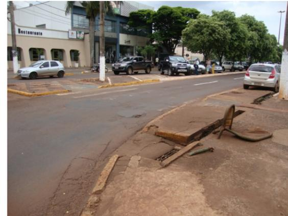
Falta de grelha protetora sobre as drenagens causando risco de lesão aos usuários.
