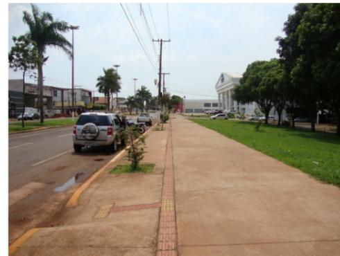
Piso podotátil colocado em conformidade com a norma.
