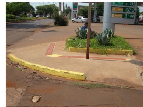
Rampa em desconformidade com a norma e piso podotátil sem continuidade.
