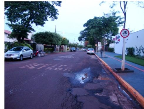
Calçada em bom estado e com piso podotátil, fica comprometida com a baixa condição da pista de tráfego.
