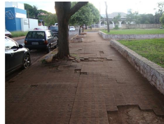
Deformidade do pavimento provocada pelas raízes das árvores e falta de manutenção.
