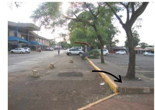
Desnível entre calçadas e abrigo de ônibus sobre a pista em ponto de ônibus com grande demanda de pessoas.
