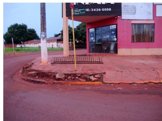
Desconformidade nas esquinas expõem o pedestre a riscos e impossibilita a travessia segura de PNEs.
