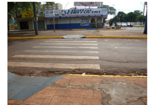
Rampas de acessibilidade em conformidade com a Norma, porém falta manutenção da calçada e da pavimentação da pista no bordo junto ao meio fio.
