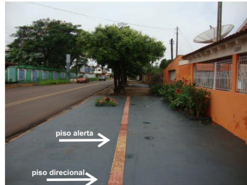
Piso podotátil colocado em desconformidade com a Norma, e confusão no uso do piso de alerta.
