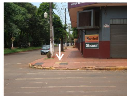
Deformidade do meio fio, ausência de rampa de PNEs e piso tátil colocado de forma irregular.
