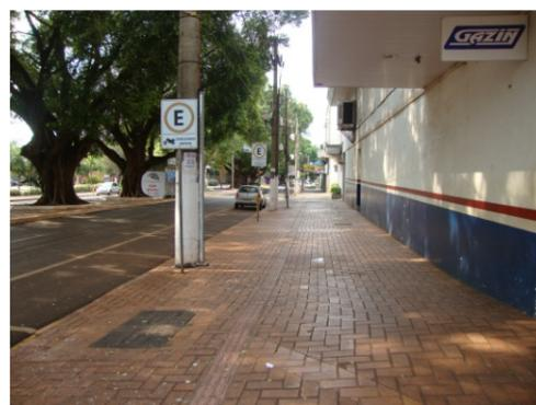
O tipo de pavimento confunde-se no contato com o piso podotátil.
