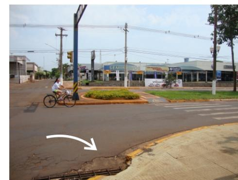
Ótimo exemplo de continuidade das rampas PNE, porém a grelha pluvial invade a área da calçada.
