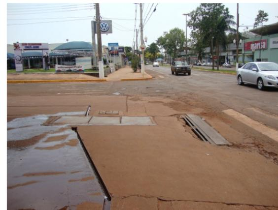
Rebaixo de meio fio contínuo e ininterrupto nas duas testadas reduz a proteção ao pedestre.
