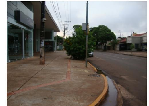
Piso podotátil colocado de forma adequada.
