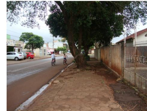
Raízes deformando a pavimentação desqualificam a calçada.
