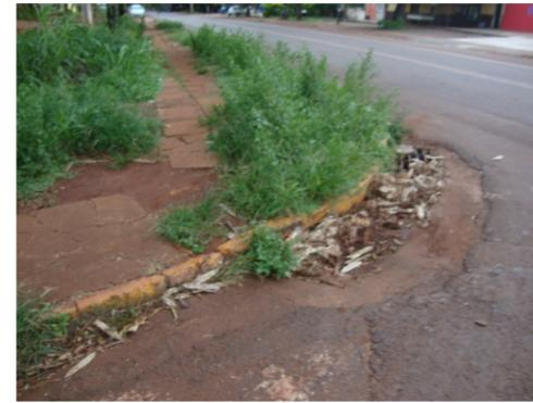
Calçada sem manutenção, com acúmulo de lixo sobre grelha pluvial e sem acessibilidade.
