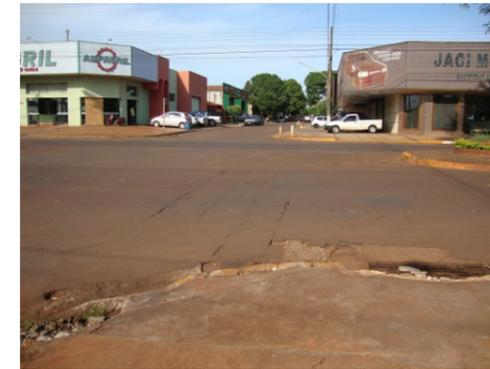
Grelha pluvial dificultando o deslocamento dos pedestres e as deformidades na esquina expõem os pedestres a riscos.
