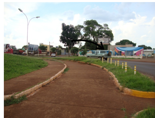
Calçada sem itens de acessibilidade defronte ao Monumento ao Colono.
