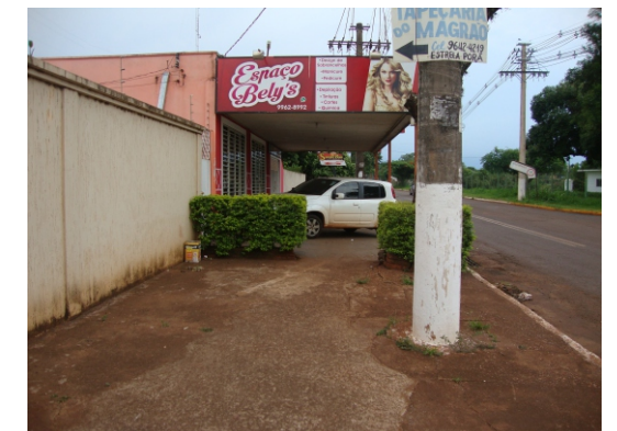
Calçada com obstáculos que oferecem risco e dificuldade para os pedestres são eles: falta de piso podotátil, automóvel estacionado sobre o passeio público e barreira vegetal.
