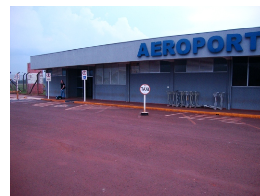
Rampa de PNE junto à vaga especial.
