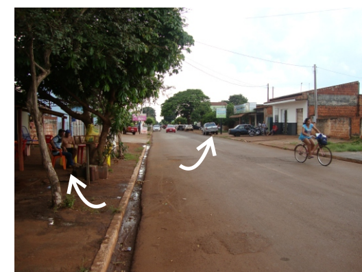
Diversos obstáculos e automóveis sobre a calçada, dificultam o deslocamento dos pedestres.
