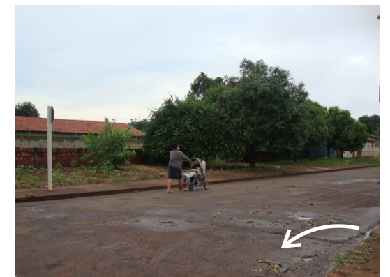
Ausência de sinalização, passeio estreito e sem manutenção impedem o deslocamento de PNEs.
