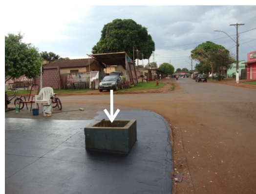
Calçada com ocupação particular, floreira que causa obstáculo e pintura de piso não regulamentada comprometem a padronização dos passeios.
