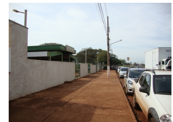
Calçada sem atratividade e sem piso podotátil.
