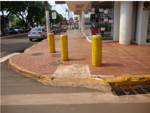
Rampa irregular e barreiras físicas desconformes, dificultam deslocamento de cadeirantes.
