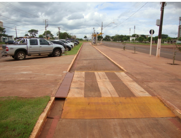
Exemplo positivo de faixa de pedestres elevada junto à ciclovia em frente a unidade de saúde.
