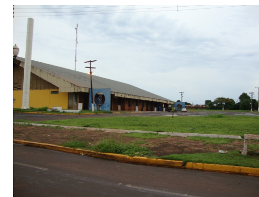
Rua Monte Alegre - próximo ao Ginásio de Esportes, percebe-se a ausência de acessibilidade, e uma vez que a calçada é desconfigurada pela falta de manutenção.
