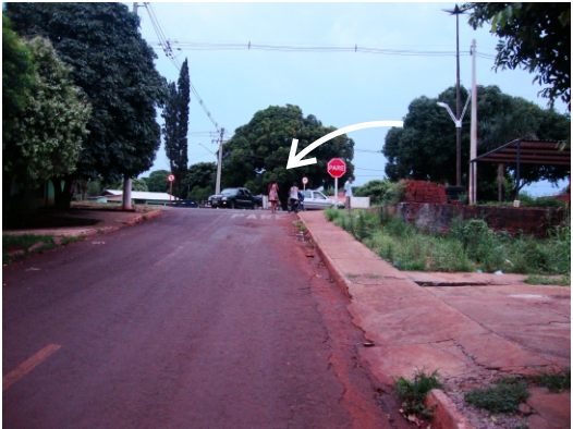
Inclinação da via aliada a falta de manutenção da pavimentação, obriga o pedestre a se deslocar pelo leito carroçável.
