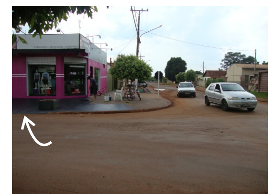
Rebaixo de meio fio sem demarcação, falta de sinalização de pistas e sem rampa para PNE.
