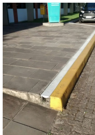
Exemplo de grelha pluvial.
