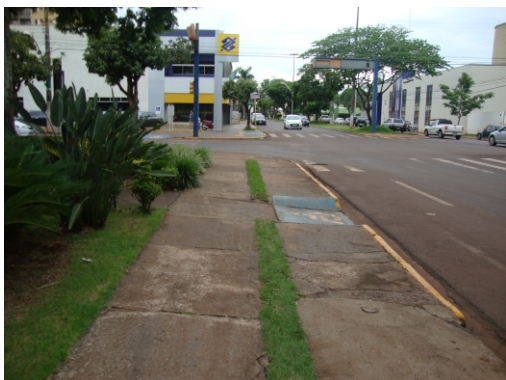
Falta de manutenção nas rampas de cadeirante no entorno.
