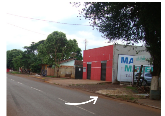
Falta de contenção de entulho de obra sobre a calçada e diversos tipos de pavimentos ao longo do trecho tornam a calçada sem atratividade.
