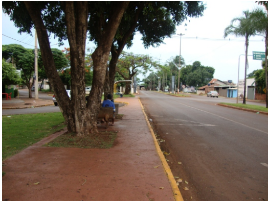
Ótima qualidade ambiental e da pavimentação, porém há falta de rampas e piso podotátil para a acessibilidade.
