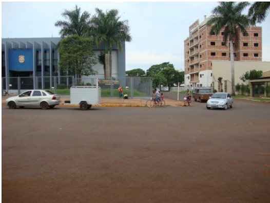
Passeio público e pistas bem conservados e com rampa de PNE, porém sem piso podotátil e falta de faixa de segurança no cruzamento.
