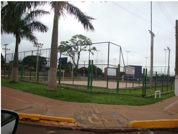
Aplicação de elementos de acessibilidade próximo de quadra poliesportiva, porém com a conservação debilitada.
