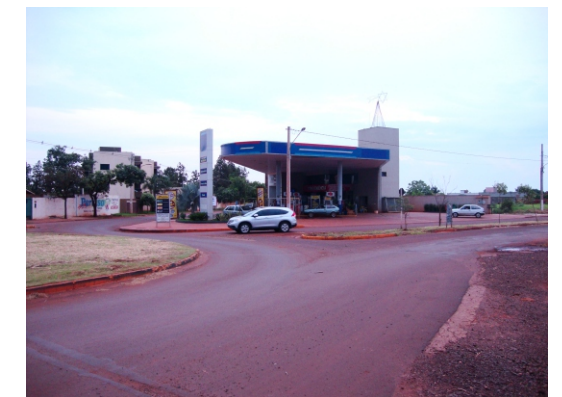
Falta de sinalização para pedestres torna o cruzamento perigoso.
