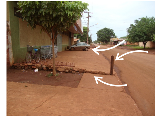
Barreiras prejudicam o deslocamento do pedestre.
