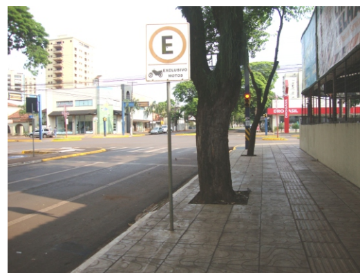
Pavimentação em ótimo estado de conservação e com piso podotátil está colocado de acordo com a norma técnica.
