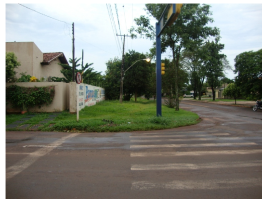
Falta de pavimentação dificulta o deslocamento seguro do pedestre.
