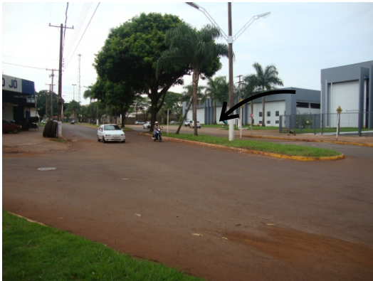
Rebaixo contínuo favorece o estacionamento na área de calçada e expõe o pedestre nas manobras de ré.
