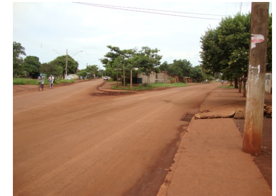
Falta de sinalização e tratamento acessível das calçadas.
