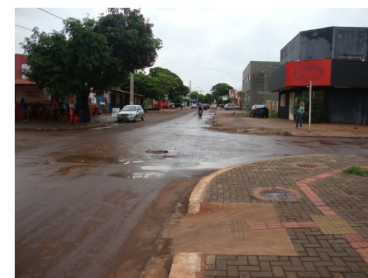
Rampa de PNE e piso podotátil em bom estado de conservação.
