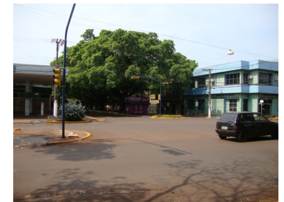
Falta de manutenção da sinalização horizontal compromete a percepção ambiental do lugar.
