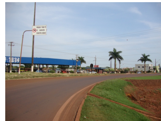
A ausência de passeios e sinalização de segurança em rodovias com circulação de pedestres podem acarretar perigo de acidentes
