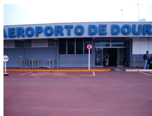
Acesso de cadeirantes defronte ao acesso principal do Aeroporto.
