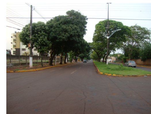
Falta de pavimentação, acessibilidade e manutenção da sinalização de trânsito.
