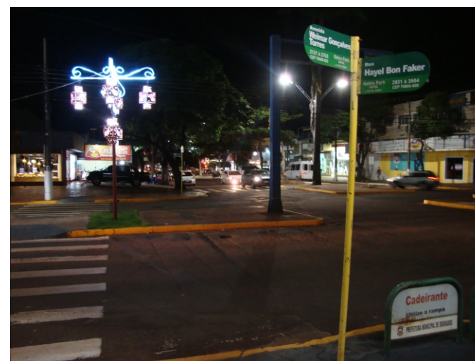
Avenida Weimar Gonçalves Torres - trecho bem iluminado, porém com pouca incidência de luz para segurança viária. Percebe-se também que a acessibilidade, embora apresente as rampas, elas não estão totalmente de acordo com a norma e no trecho não apresenta complemento por piso podotátil.
