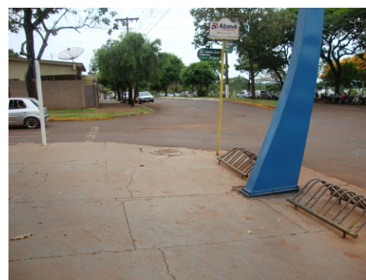
Falta de rampa para PNE, piso podotátil e má conservação do mobiliário urbano.
