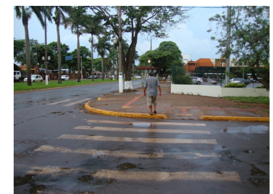
Rampas de acessibilidade e piso podotátil em conformidade com a norma.
