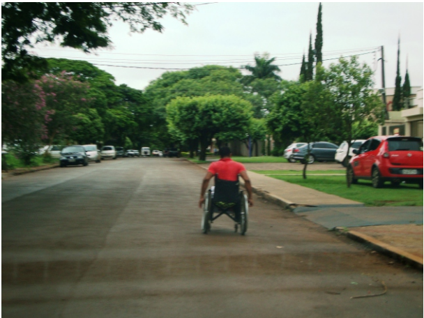
Falta de rampa junto a faixa de travessia obriga o cadeirante a transitar no leito carroçável.
