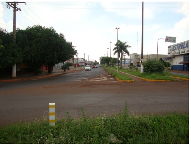
Ausência de sinalização e manutenção para proteção do pedestre e ciclista.
