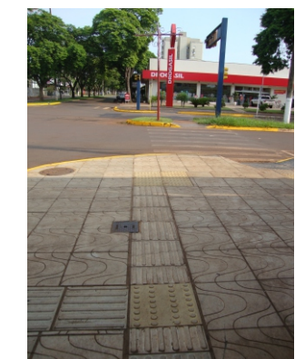
Piso podotátil de acordo com a Norma.
