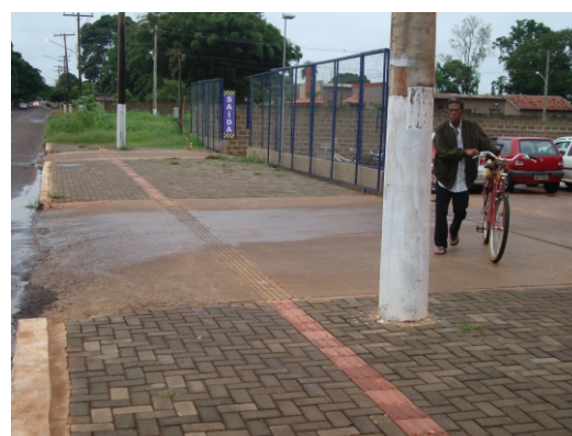
Piso podotátil colocado de forma correta, pavimentação com boa qualidade.
