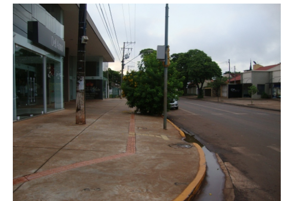
Piso podotátil colocado de forma adequada.
