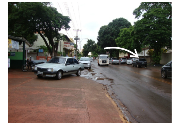
Automóveis estacionados sobre a calçada de forma desordenada danificam o rebaixo de meio fio, deixam o pedestre sem alternativas de deslocamento.
