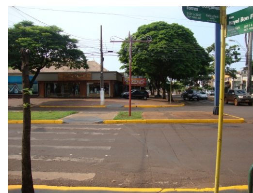
Faixas de pedestres carecem de manutenção.
