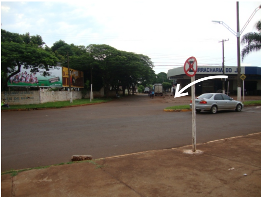
Deterioração da calçada em esquina aliada a falta de acessibilidade e falta de sinalização expõe o pedestre a riscos.
