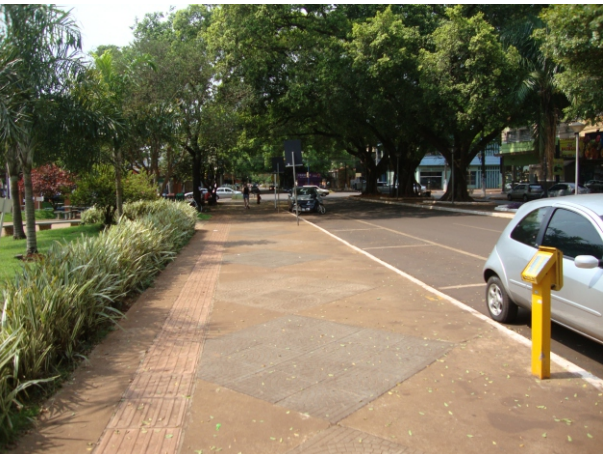
Passeio público implantado de forma qualificada e com posicionamento seguro do piso podotátil.
