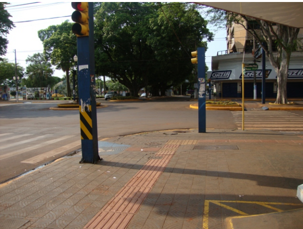
Importante exemplo de qualidade do passeio, com boa manutenção da pavimentação, piso podotátil e qualidade da legibilidade.
