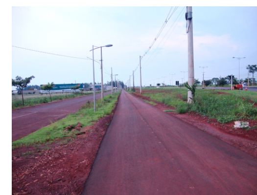
Falta de pavimentação do passeio prejudica o deslocamento de pedestres.
