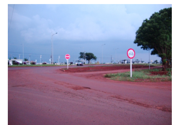
Falta de passeio público, sinalização para pedestres e ausência de faixa de segurança.
