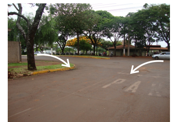
Boa qualidade ambiental, porém falta de manutenção da pintura da via e rampas de PNE.
