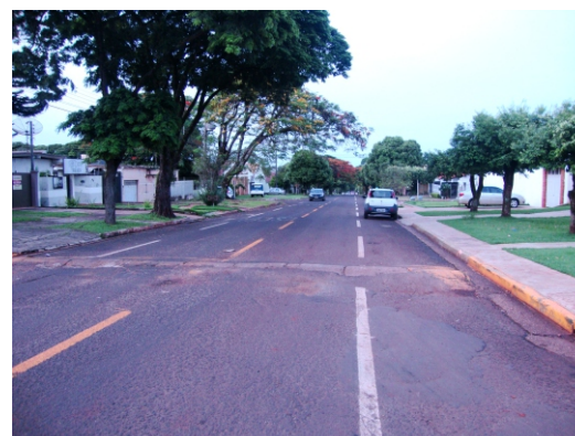
Calçadas sem padronização das faixas técnicas compromete a leitura urbana adequada.
