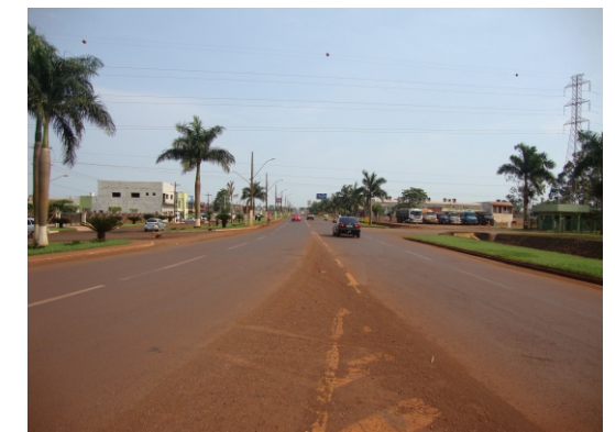
Falta de faixa de segurança e sinalização acerca de pedestres e ciclistas.
