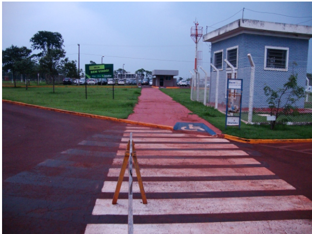
Acesso ao aeroporto de Dourados conforme para o deslocamento de pedestres e acessibilidade.
