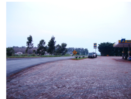
Ótima conservação do pavimento, porém o fluxo contínuo de veículos de carga e a falta de um espaço protegido para pedestres compromete a segurança.
