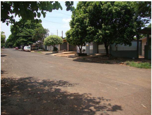
Calçada com degraus e rampas inadequadas priorizando apenas o acesso de veículos.
