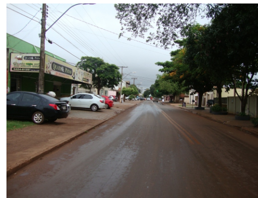
Veículos estacionados sob calçada expõe o pedestre a riscos nas manobras de ré.
