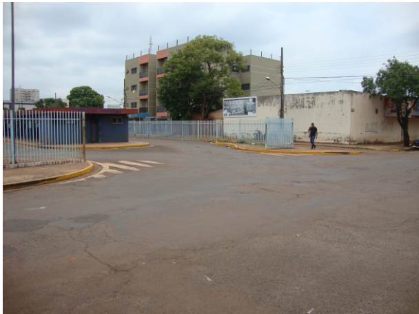
Entorno do Terminal Urbano com inexistência de elementos de acessibilidade..
