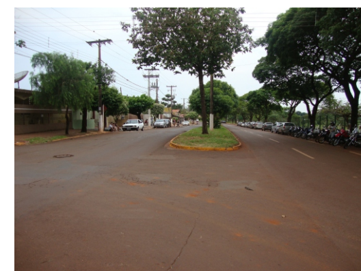
A ausência de faixa de segurança e sinalização para pedestres em um local de fluxo intenso de automóveis e pedestres pode causar acidentes e dificultam a mobilidade urbana.
