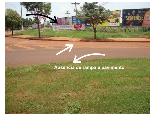
Propaganda implantada em local indevido impede o deslocamento do cadeirante.
