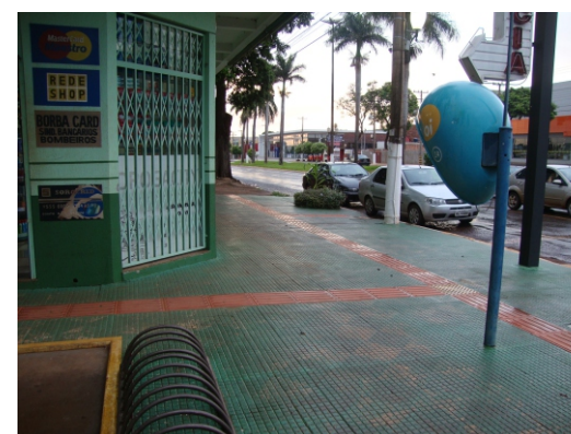
Pavimentação e piso podotátil em bom estado de conservação e a presença de paraciclos são itens que qualificam a mobilidade urbana .
