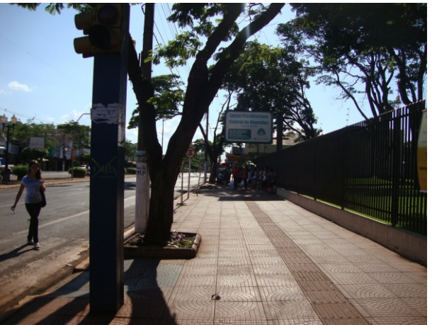
Passeio amplo e com sinalização podotátil, apenas necessitando de adequação na rampa de PNE.
