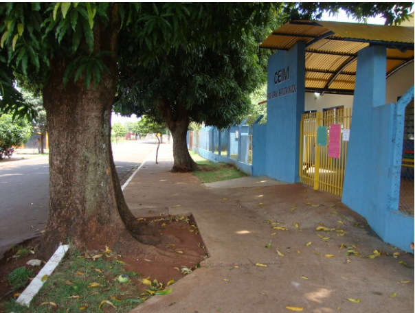
Conflito entre arborização e composição da calçada.
