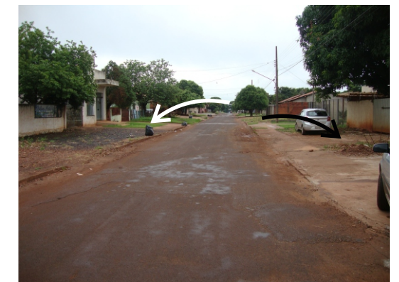
Falta de lixeiras e manutenção das calçadas.
