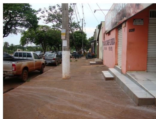
Sucessão de obstáculos no deslocamento dos pedestres, desqualifica a calçada.
