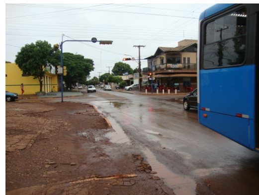
Completa degradação da calçada e falta de acessibilidade na rota do transporte coletivo.
