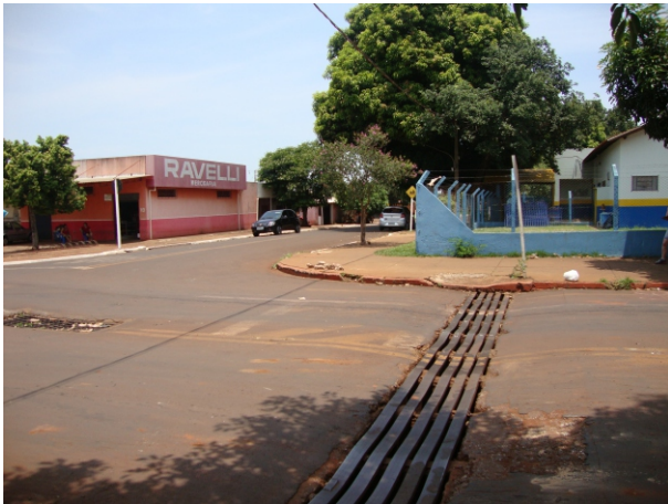
Grelha pluvial próxima a escola, compromete a qualidade visual do cruzamento.
