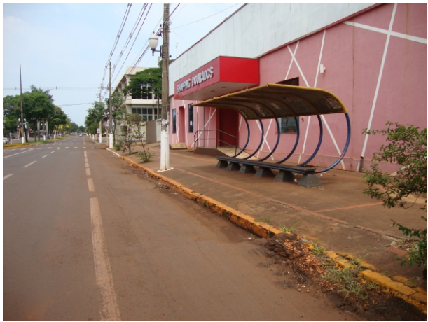
Inadequação na passagem do abrigo para o ônibus: rampa descendente na faixa técnica.
