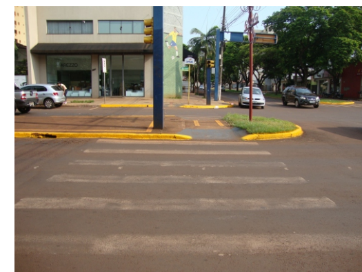
A continuidade das rampas influencia positivamente a mobilidade, mas é importante a manutenção na pintura da faixa de pedestres.
