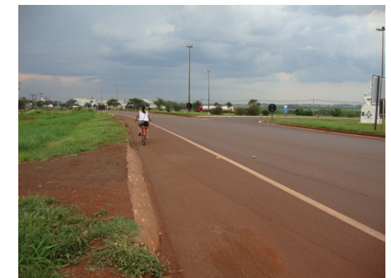
A falta de passeio para pedestres e a sinalização necessária faz com que o pedestre se sujeite a situações de risco junto ao acostamento.
