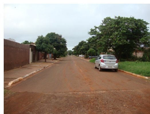
Calçada sem pavimentação e diversos rebaixos de meio fio dificultam o percurso.
