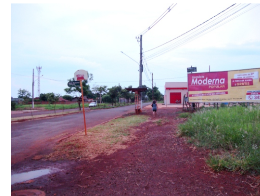
Falta de pavimentação ao longo do passeio público dificulta o deslocamento do pedestre.
