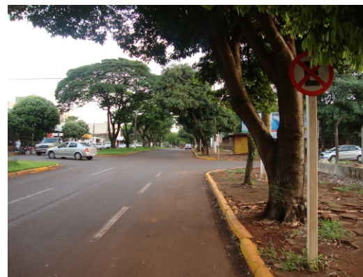
Raízes das árvores prejudicam a pavimentação das calçadas.
