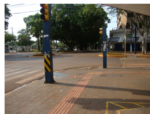
Exemplo de calçadas acessíveis, com ótima qualidade visual e ambiental.
