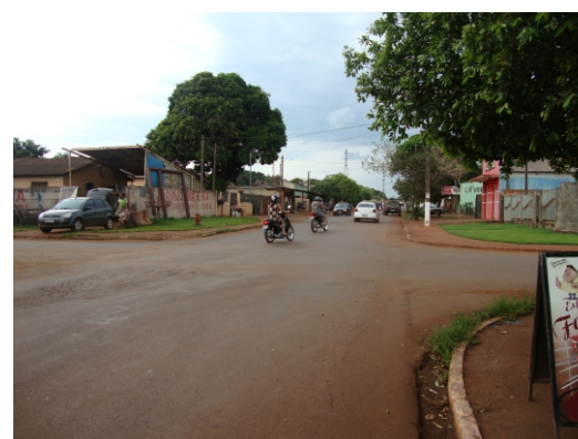
Esquinas sem tratamento de sinalização e meio fio carece de manutenção.
