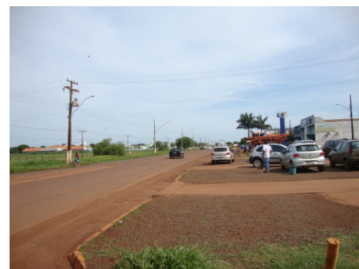
Ausência de segregação entre calçada e estacionamento expõe o pedestre a riscos.
