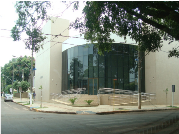
Requalificação de acesso em conformidade no Fórum de Dourados.
