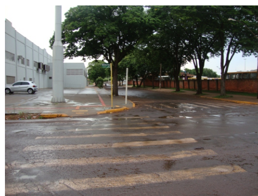
Piso podotátil continuação das rampas de PNE com boa qualidade ambiental.
