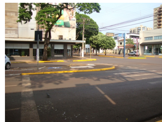
Calçadas do cruzamento com boa qualidade visual e com atendimento à acessibilidade.
