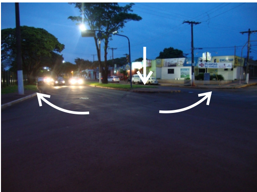
Falta de continuidade das rampas de acessibilidade dificulta o deslocamento do cadeirante.
