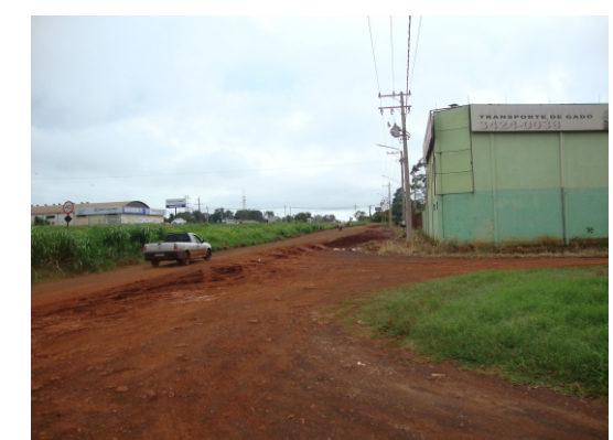
Ausência de área de calçadas e nenhuma sinalização de trânsito.
