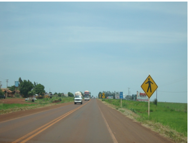
Ausência de passeios e de sinalização adequada, induzem à situações de total insegurança.
