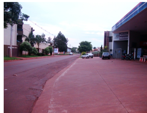
Rebaixo contínuo do meio fio para beneficiar o automóvel expõe o pedestre a risco.
