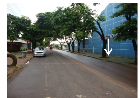
Ausência de piso podotátil na calçada e a rampa de PNE no meio da quadra é quase despercebida.
