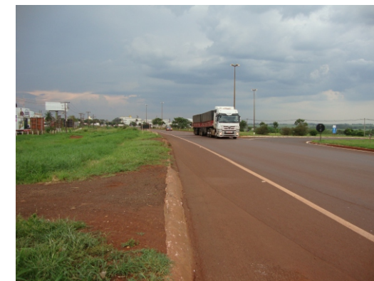
Falta de sinalização para pedestre e ciclovia traz insegurança ao cruzamento.
