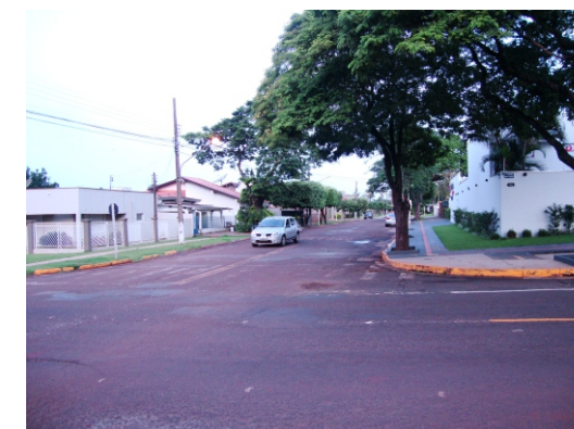
As calçadas do cruzamento necessitam de tratamento das interseções em questões de acessibilidade.
