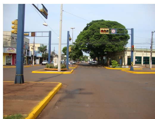
Tratamento de esquinas com semaforização apenas para veículos, mas foco para pedestres se encontra sem operação .
