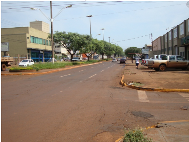
Estacionamento sobre o passeio expõem o pedestre a risco nas manobras de ré.
