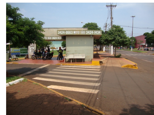
Rampa sem correspondência na calçada oposta.
