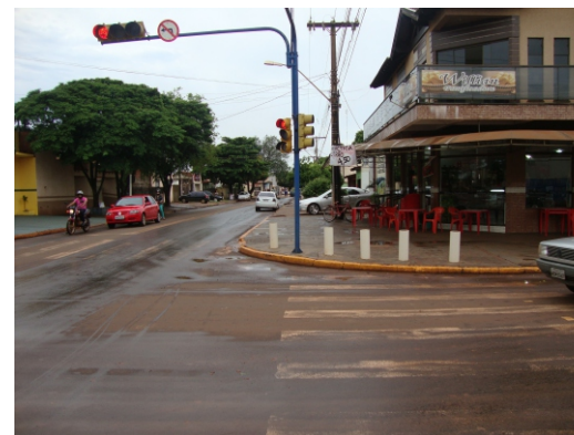
Calçada sem acessibilidade e barreiras de cadeirantes e PNEs.
