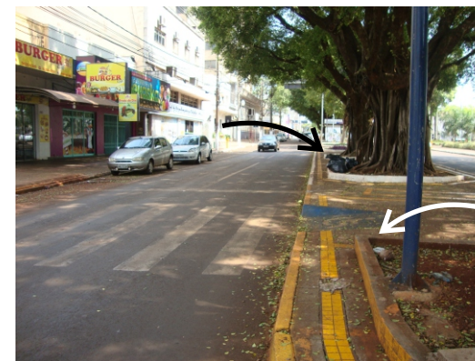
Lixo nos canteiros comprometem a salubridade das calçadas.
