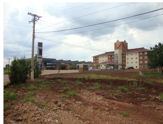
Falta de calçada para pedestres próximo a zona industrial.
