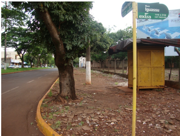
Descaracterização pela manutenção ineficiente do piso bloquete sextavado.
