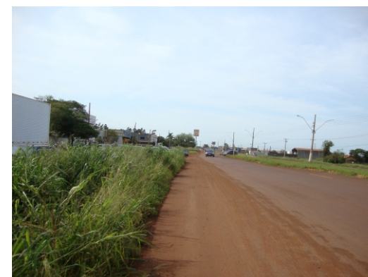
A ausência de calçadas e sinalização horizontal traz riscos aos pedestres em área institucional.
