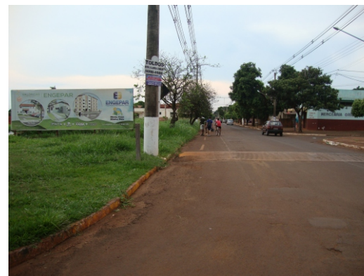
Falta de pavimentação no lado esquerdo da calçada, ausência da faixa de pedestre e itens de acessibilidade universal.
