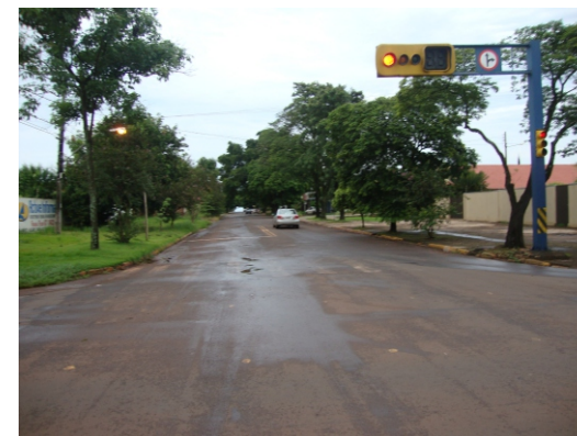
Falta de atratividade e manutenção decorrentes da vegetação interferindo nas calçadas.
