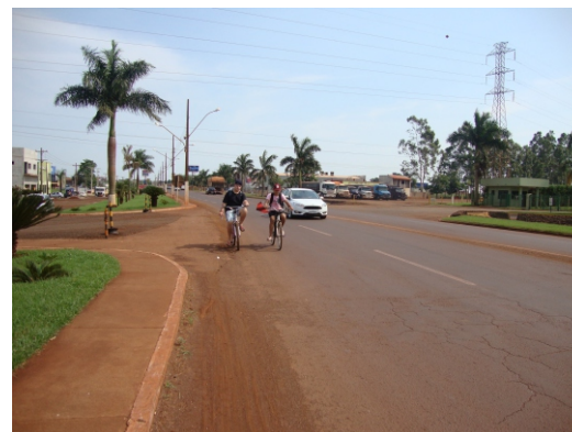
Calçada sem tratamento e sem acessibilidade.
