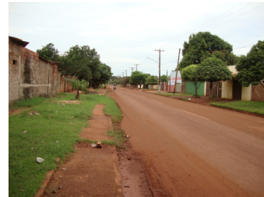
Sucessão de obstáculos e tipos de pavimentação variadas dificultam o percurso do pedestre.
